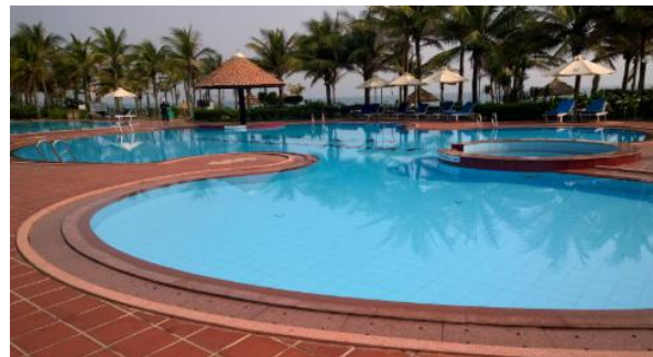
洗浴中心、游泳馆等用热水
